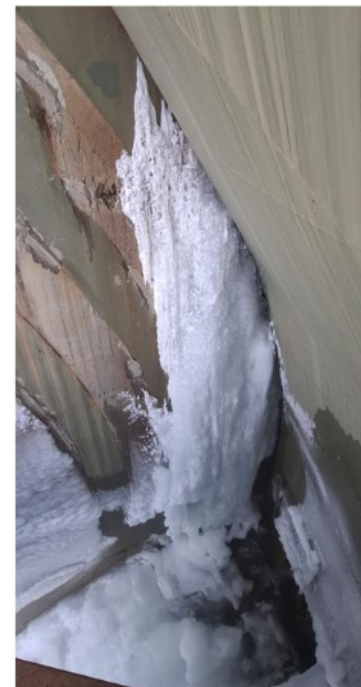
Lucka A 260216. Läckage med ispåbyggnad över nästa hela skibordet. Läckage genom sidotätning.
