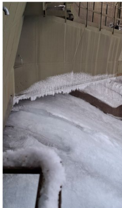
Lucka A 260216. Läckage med ispåbyggnad över nästa hela skibordet. Läckage genom sidotätning.
